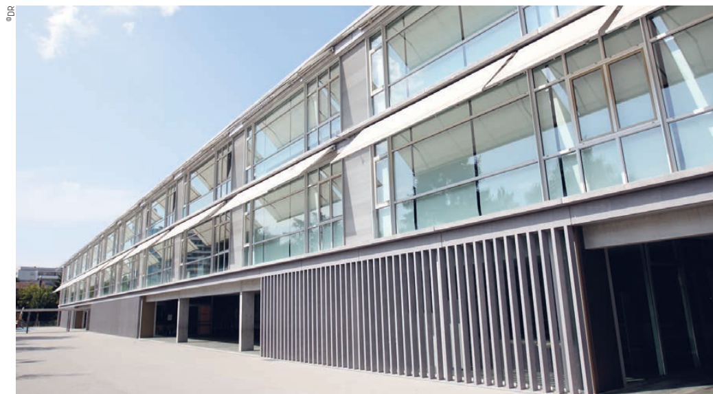
L'école Marcelly abrite la chaufferie centrale du réseau de chauffage à distance desservant dix bâtiments communaux.
